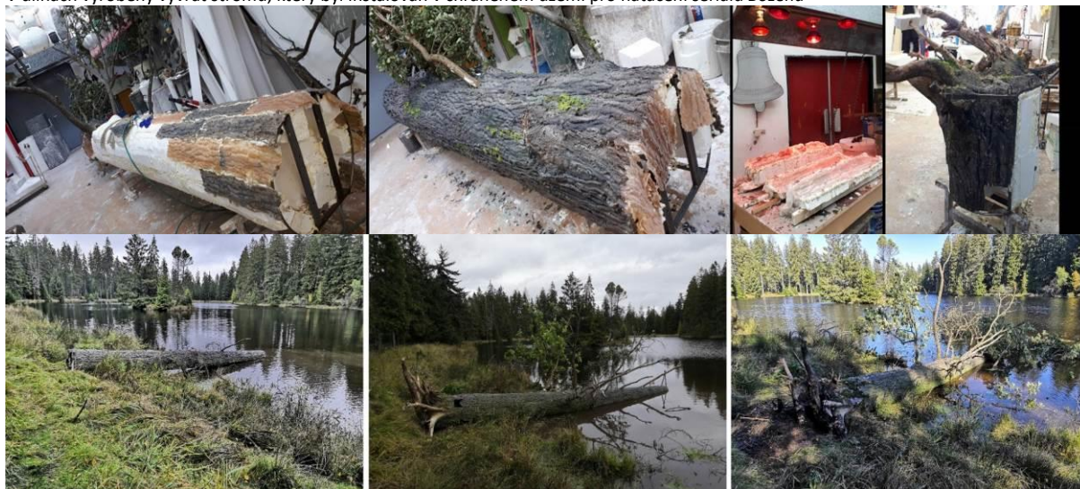
V dílnách vyrobený vývrát stromu, který byl instalován v chráněném území pro natáčení seriálu Božena
